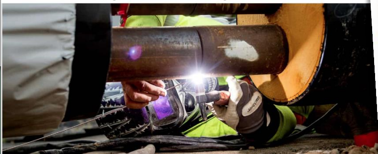
Nu skal der lægges fjernvarmrør til Almind, og det kommer til at genere trafikanterne på Højvangen. Foto: Morten Pape
